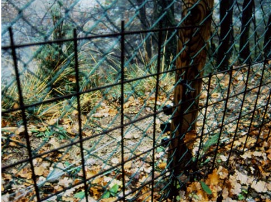
Foto 5 Particolare della base della recinzione.
